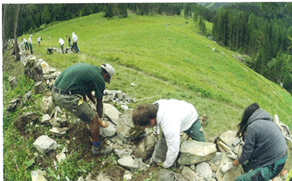
Lehrlinge aus fünf Genossenschaften stellten in Berggün eine Natursteinmauer instand.
